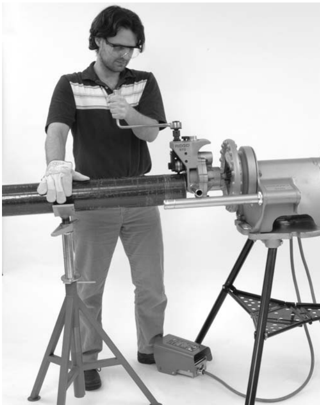
Figure 13 – Appuyer sur le tuyau pour maintenir son alignement durant le rainurage.
