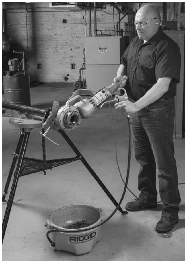
Figur 9 – Gevindskæring af rør
