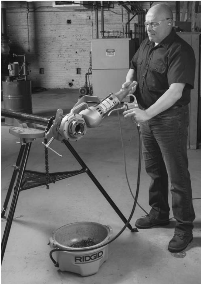
Abbildung 9 – Gewindeschneiden in Rohr
